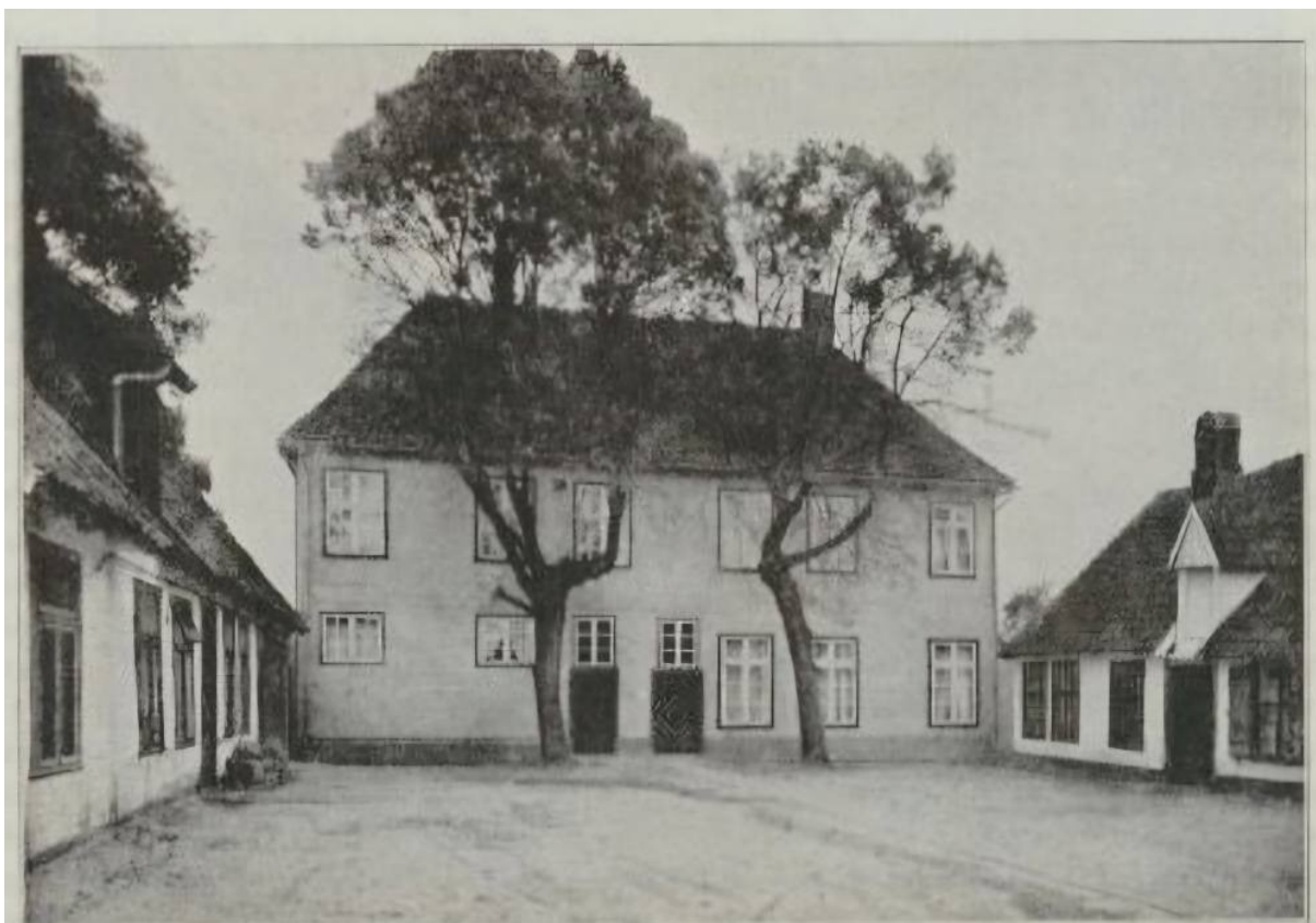
Abb. 334. Quakenbrück. — Burgmannshof Nr. 6.
